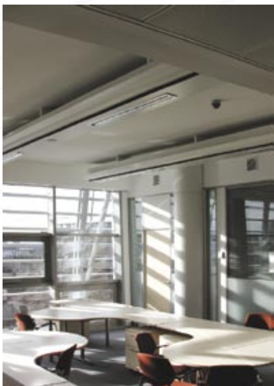
Ailes décoratives microperforées, éclairage indirect T5, sprinkler intégré.
