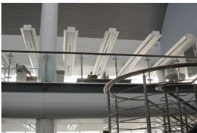
Ailes décoratives microperforées, éclairage indirect T5, sprinkler intégré.
